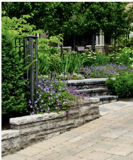
Жесткая конструкция с использованием вяжущих в значительной степени способствует стабильности положения. Соотношение формата элементов покрытия (размеров плиты) и их толщины также играет решающую роль. Так как при нагружении крупноформатных плит на швы воздействуют более высокие усилия, толщина плит и высота швов также должны выбираться большего размера.
